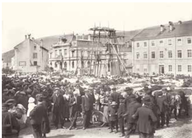
DR - Léo DURUPT Monuments aux Morts en construction
